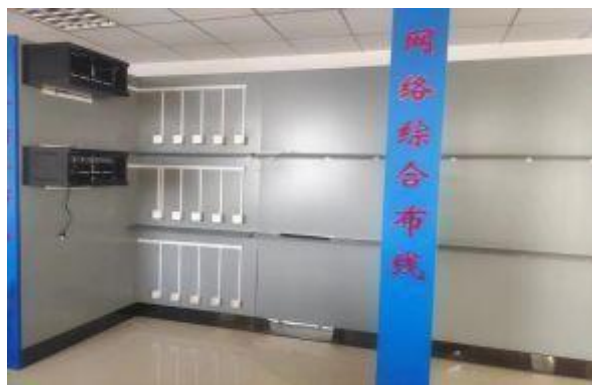
图 2.6-8 综合布线实训室（来源：信息中心）
